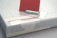
4 付属のヘラで主剤と硬化剤を混ぜ合わせます約5～8分で硬化し始めますので、素早く混ぜます \*この時気泡が入らないよう注意してください
