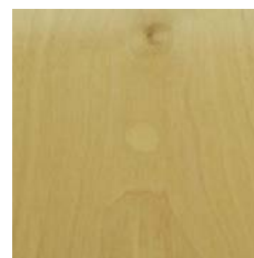
補修箇所に サンディングスプレーを 吹き付けます
